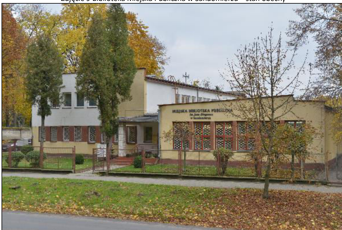
Zdjęcie 9 Biblioteka Miejska Publiczna w Sandomierzu – stan obecny
